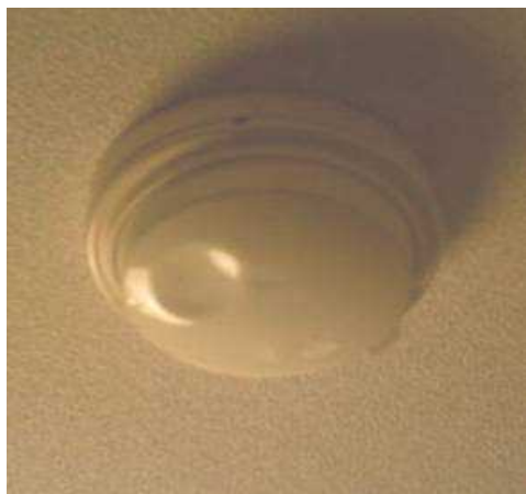
差動式スポット型感知器の変形（空気室の凹み）
